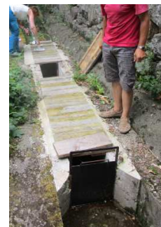
Section bétonnée béal de Chenevrières.
