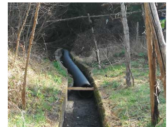
Section en tuyau canal du Tourrel, travaux réalisés en 2012.
